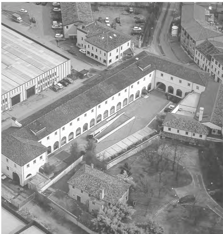
Porzione della vecchia Lazzaris divenuta Centro direzionale della Fassa Bortolo dopo il restauro del 1993
