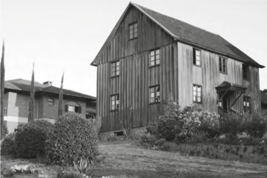
Caminhos das Pedras, Bento Gonçalves, Rio Grande do Sul, Brasile
