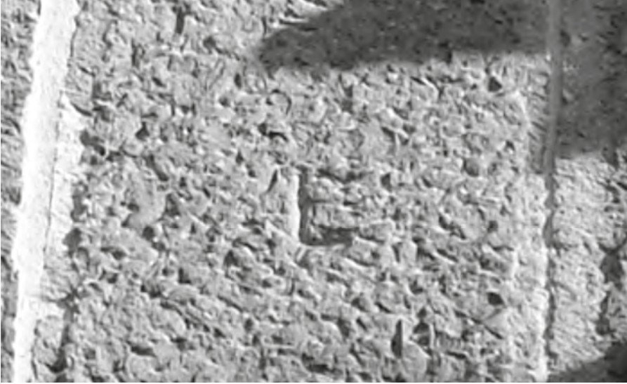
Fig 2 - Marche sulla porta san Giovanni, Padova (foto Ferdy H.B.)
