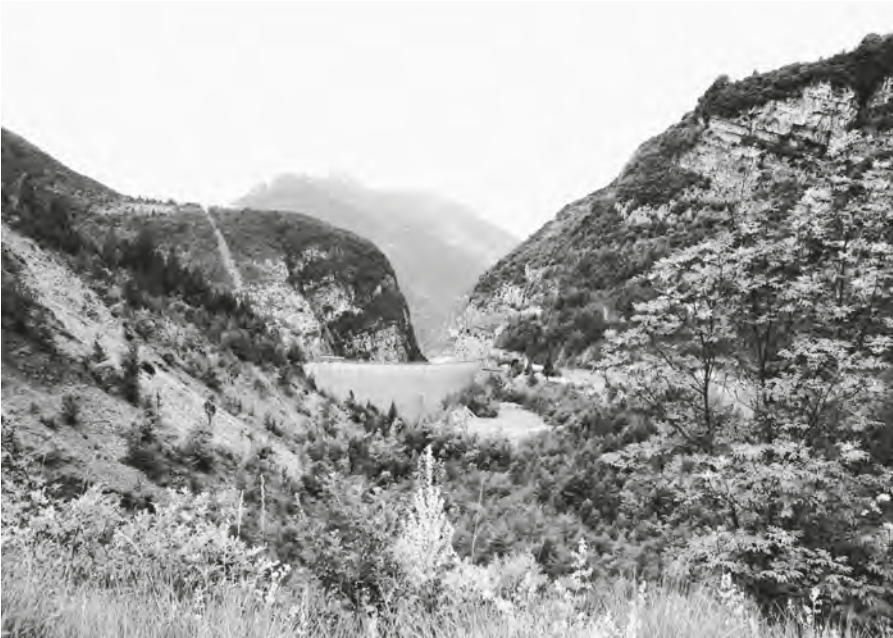
La diga con la frana oggi
