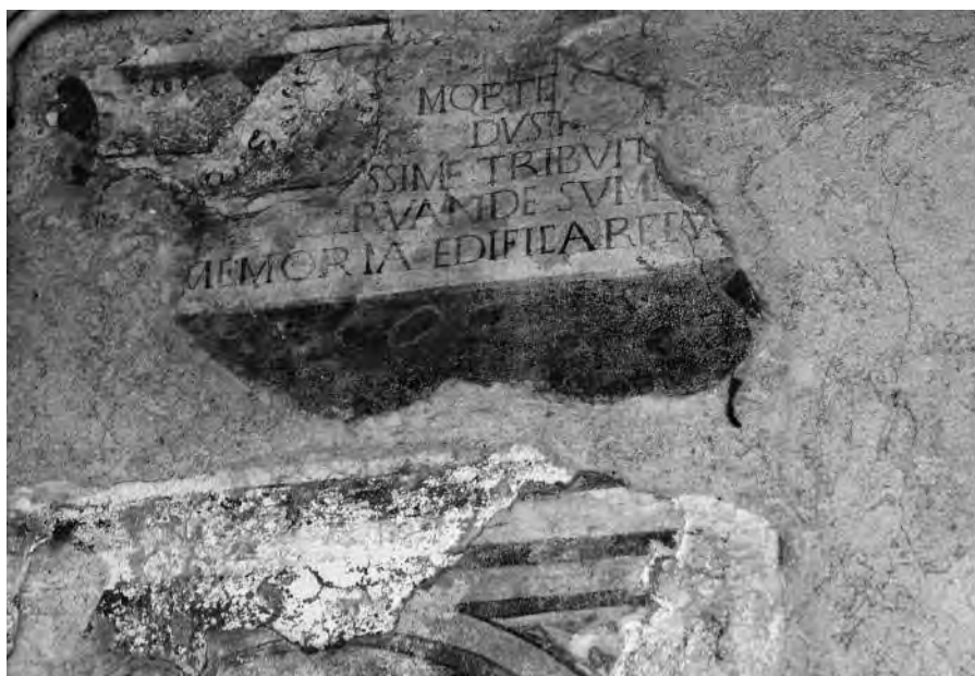
Interno della loggia. Il frammento di iscrizione coevo a quello del 1455.
