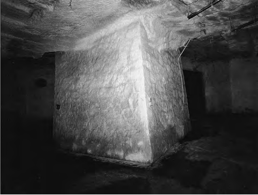
Figura 10 – Intervento di risanamento eseguito dal Conte Alvise Da Schio in un periodo interposto tra le due guerre mondiali, circa ottanta anni fa.
