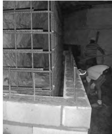
Figura 14 – Caso del confinamento passivo, con armatura tradizionale in una rifodera perimetrale di calcestruzzo armato. Ideogrammi dell'armatura da inserire nell'involucro della nuova corteccia di getto.
