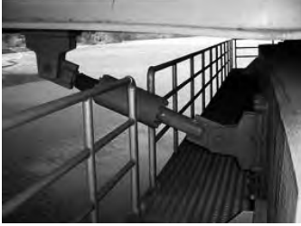
Fig. 8. Dissipatore di energia VISCOSO (immagine tratta da FIP industriale). I pezzi di questa natura sono essenzialmente costituiti da un cilindro riempito con fluido siliconico e da un pistone che crea due camere, libero di muoversi in entrambe le direzioni. La dissipazione di energia avviene tramite la laminazione del fluido siliconico nel circuito idraulico.
